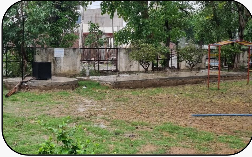
फरीदाबाद में निर्मित एक आर्टिफिशियल रिचार्ज सिस्टम (डिसिल्टिंग चेंबर, फिल्टर और रिचार्ज बोरवेल)
